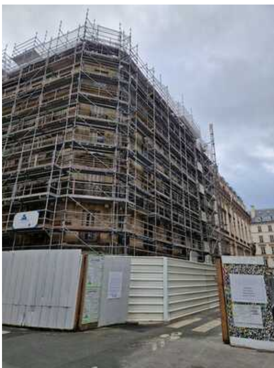
Travaux de réhabilitation de la rue de Trévise actuellement menés.
